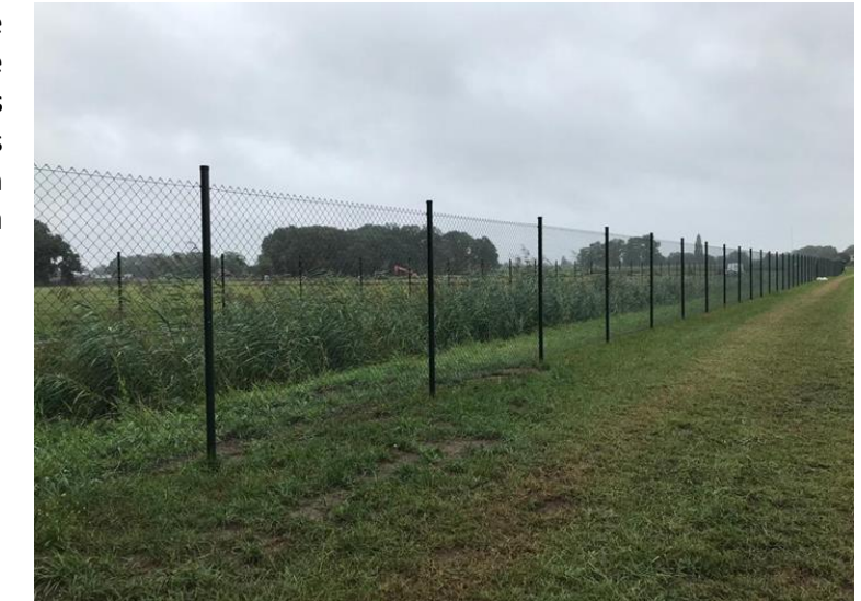
Figure 12 : Exemple d'une clôture
