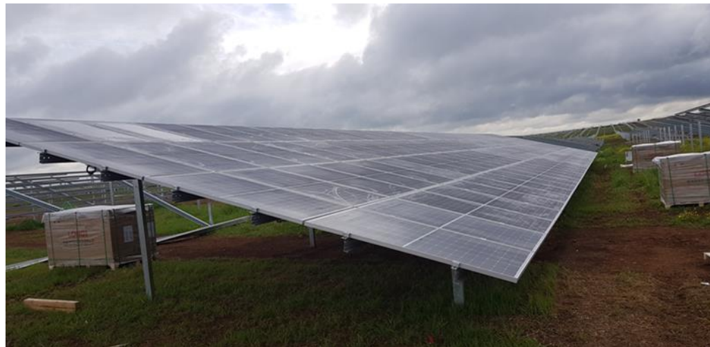
Figure 7 : Installation de modules pour le projet de Bienvenida (ESP)
