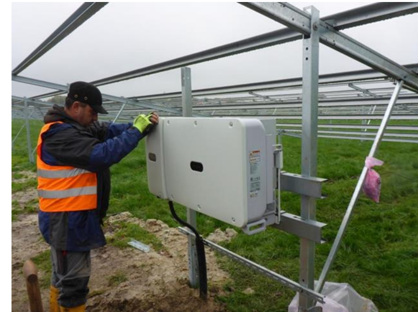
Figure 9 : Fixation d'un onduleur décentralisé
