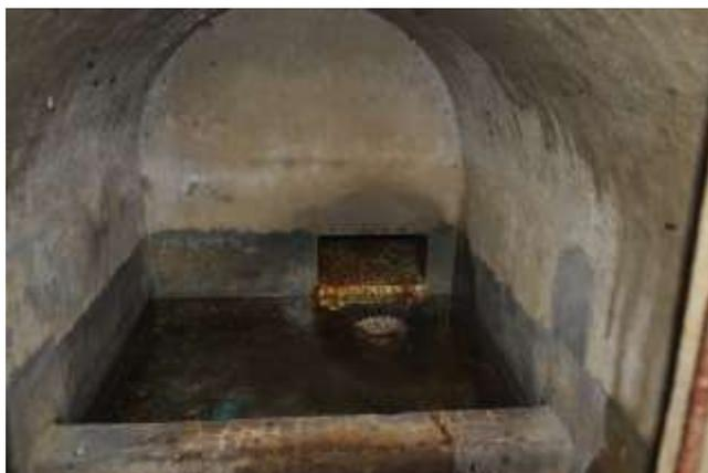
Le captage communal est constitué d'un réceptacle parallélépipédique de 1,5 m sur 1,3 m et de 0,64 m de profondeur.
