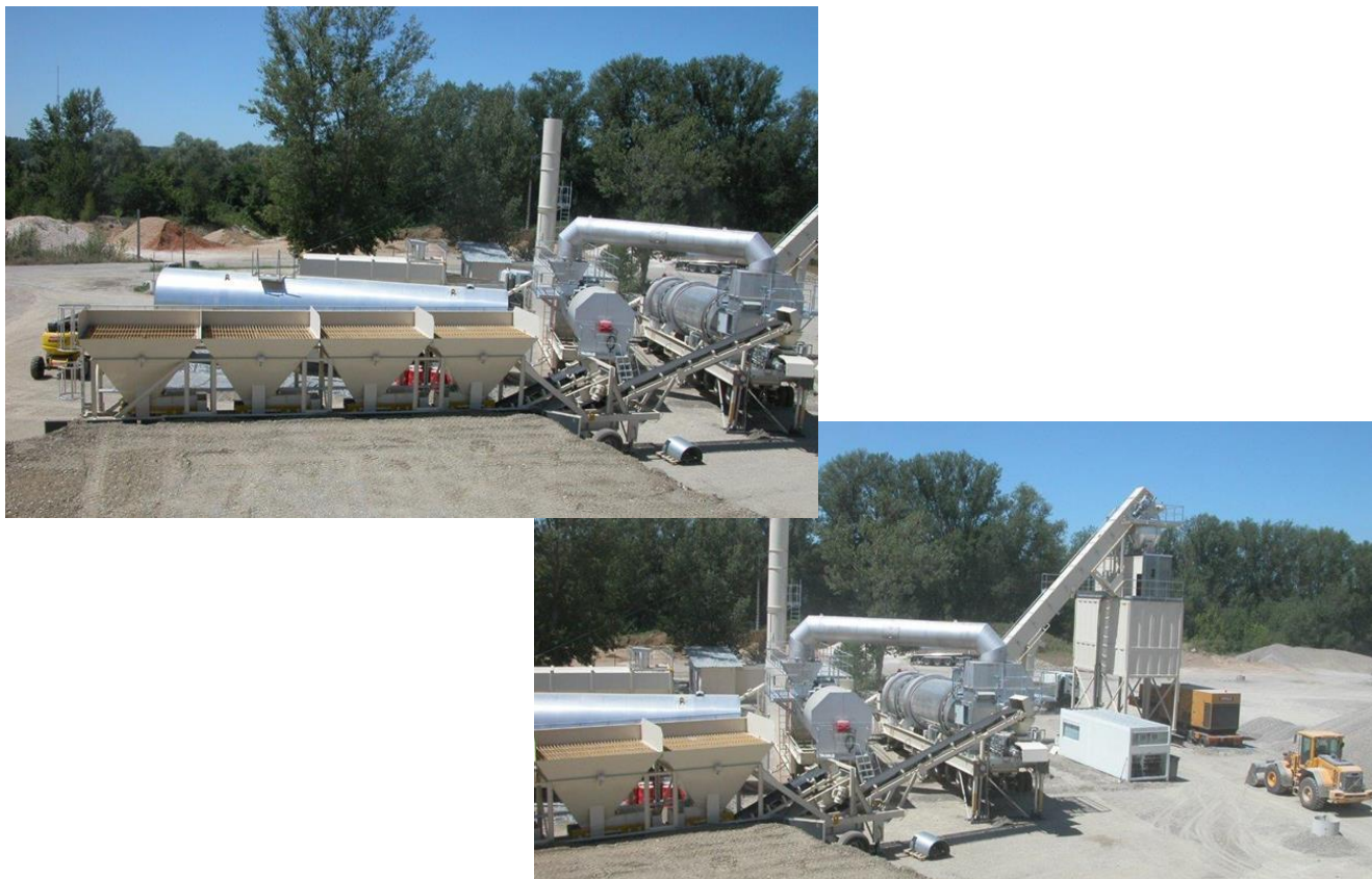
Illustration n° 7 : Photographie d'un poste d'enrobage de type RF400
